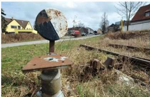
Die Trasse der Bibertbahn ist nur noch als Stückwerk erhalten. Was der Wiederaufbau kostet, soll das Gutachten unter anderem klären. Foto: H.-J. Winckler
